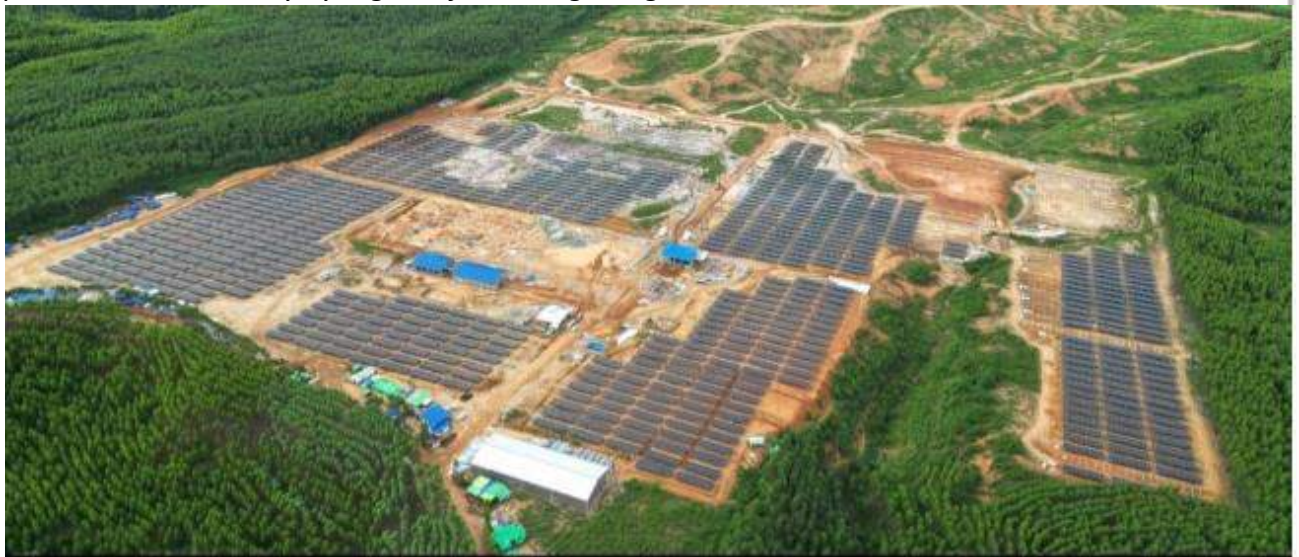
Tampak aerial foto oleh drone di Kawasan PLTS 50 MW di IKN.
