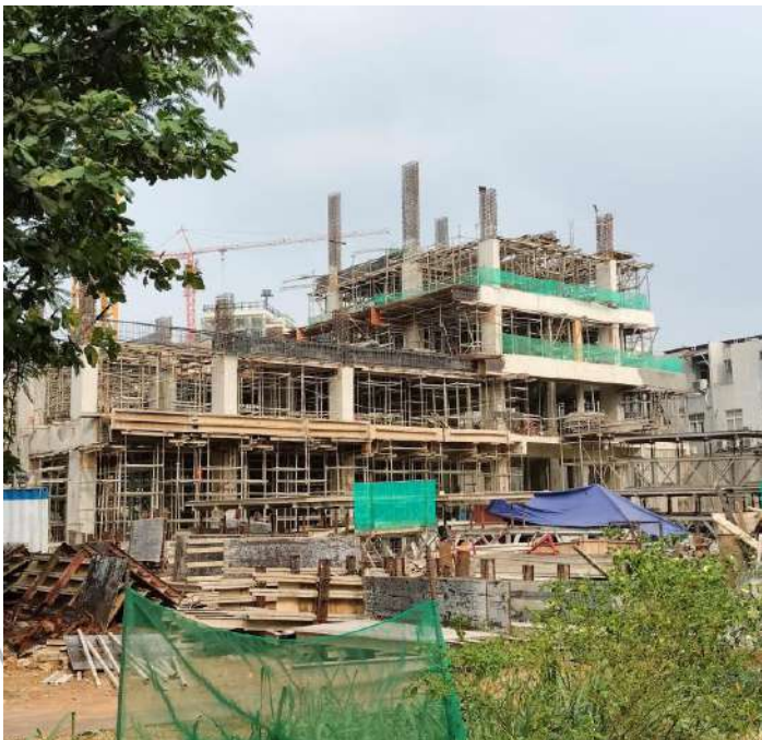
Pembangunan hotel Sol Marina di Alam Sutera Tangsel
