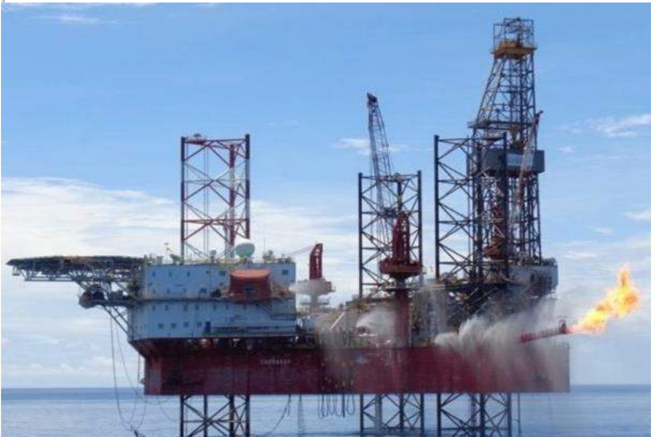
Rig offshore pengeboran sumur eksplorasi West Belut-1 di Blok B West Natuna yang dioperasikan oleh Medco E&P Natuna.
