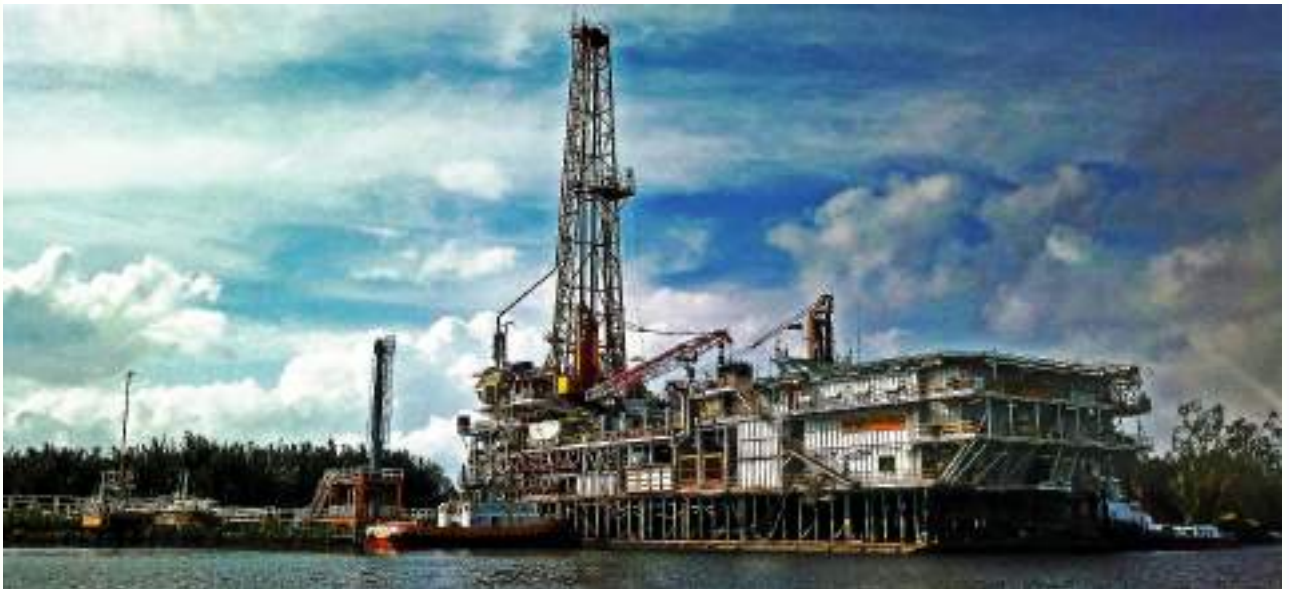
Lapangan Tunu PT Pertamina Hulu Mahakam
