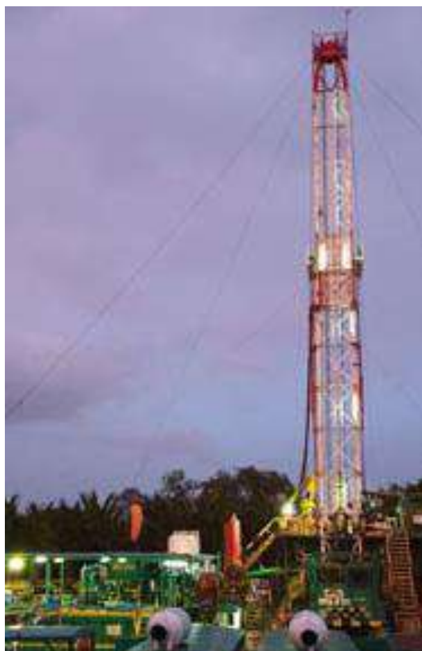
Rig onshore #09 dari BMA Drilling
