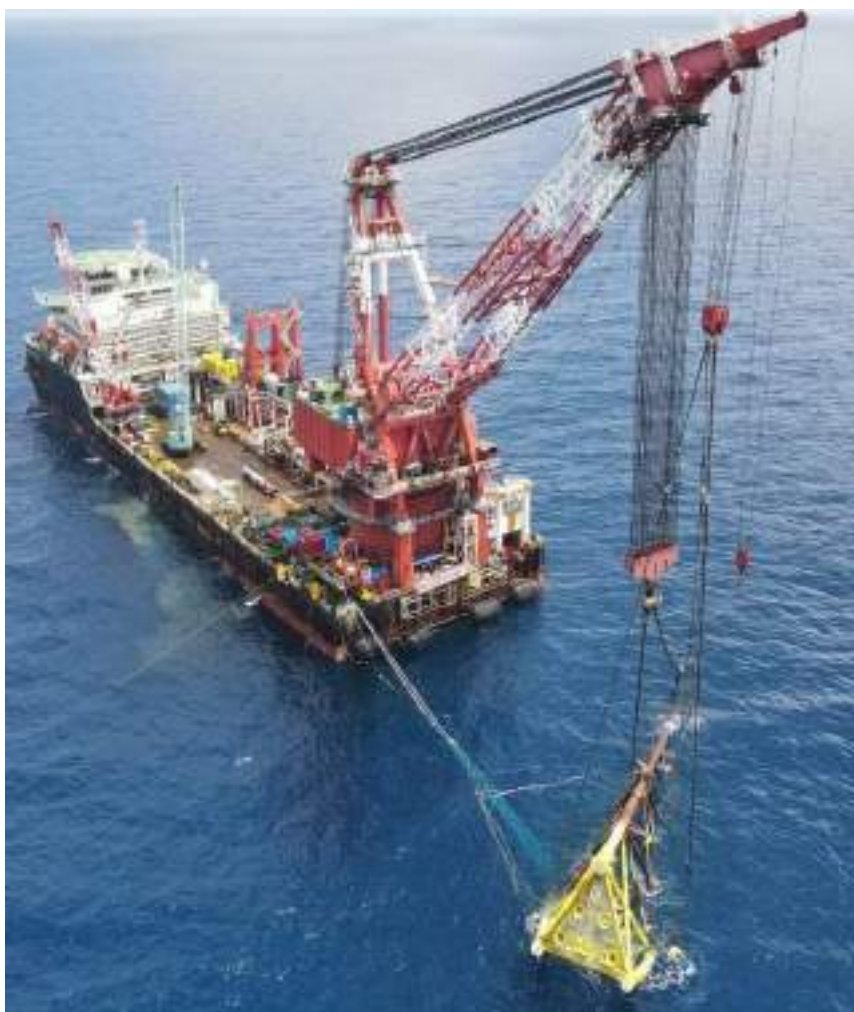
Offshore Vessel EN 3000 sedang bekerja di proyek MEINDO ELANG INDAH
